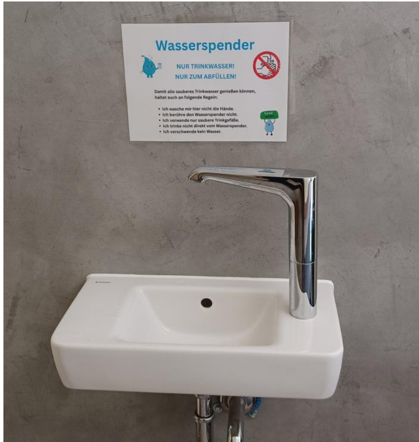
Selbstspülende Armatur von Schell regelmäßiger Wasserwechsel unterstützt den Erhalt der Wassergüte
